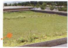
● 総合科学部棟1F、屋上10cm緑化施工場所と未施工の温度差検証中(2005.4施工)
