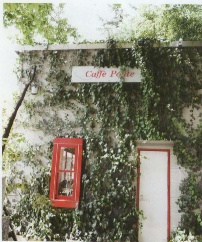
● 壁面緑化(TECOフォーム植栽キットを活用)
