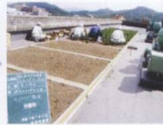
● 植栽植え付け作業
