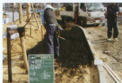
● 竹炭敷設工事
