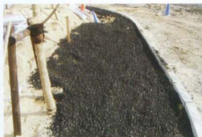
● 竹炭敷設完了
