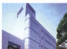
●テラルテクノサービス(株) 環境循環リサイクル資材製造供給 設備機器メンテナンス・改修業務
