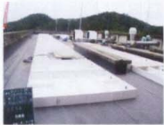
● テコフォーム受け皿ボックス組み立て作業
