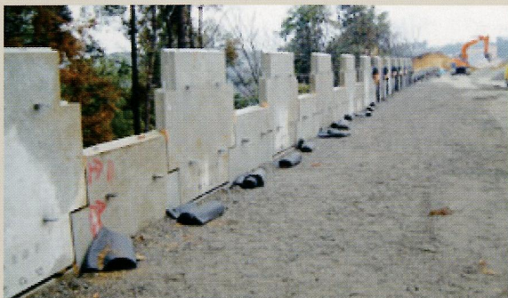
テールアルメの裏込材として活用
