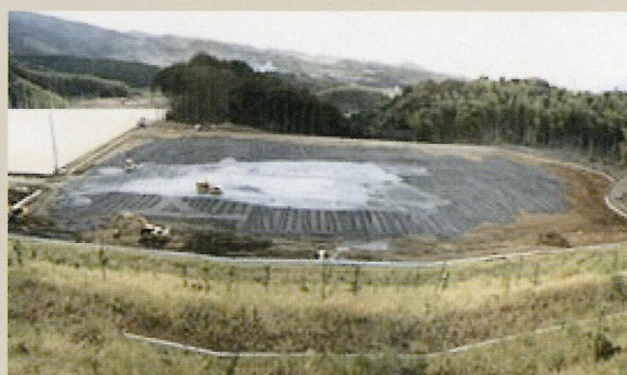
グラウンドの排水材として活用
