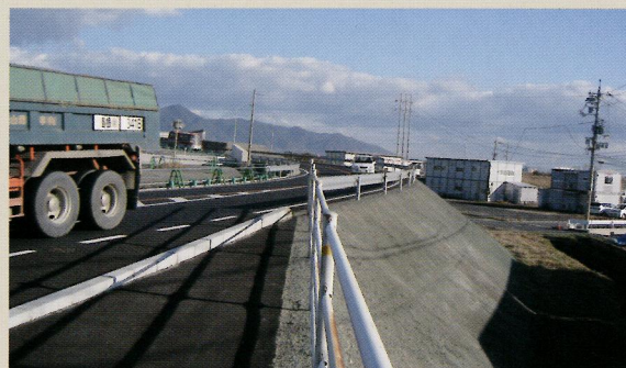
軽量盛土として活用(内部摩擦角が大きいいため急勾配での施工が可能)
