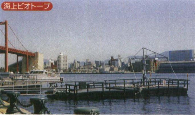
海上ビオトープ ムラサキイガイを用いた水質浄化実験プラント(北九州市洞海湾)
