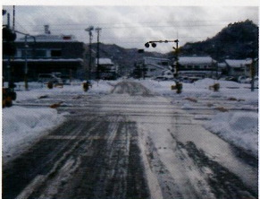
南会津鉄道踏切 福島県南会津町
