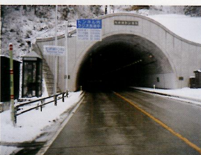
R49 七折峠トンネル・坂本 BP 福島県河沼郡
