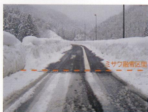
滋賀県長浜市 R303 金居原バイパス 滋賀県長浜市
